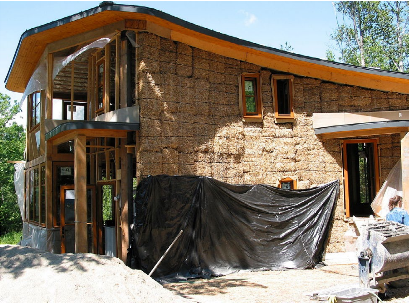
Bildquelle: Building a straw-bale house, Designed by Carina Rose von Colin Rose, lizenziert unter CC-BY SA 2.0, auf Flickr https://commons.wikimedia.org/wiki/File:Straw_Bale_House07.jpg
